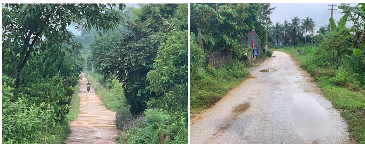
Hình 1.3: Hiện trạng tuyến tại Km5+200 ÷ Km5+741.39 và tại Km5+741.30 -:- Km6+115.21
